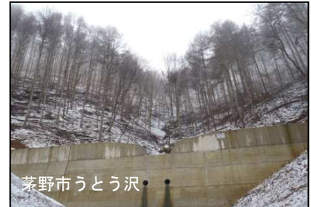
森林整備と谷止工により山腹崩壊、土石流の防止を図った箇所
