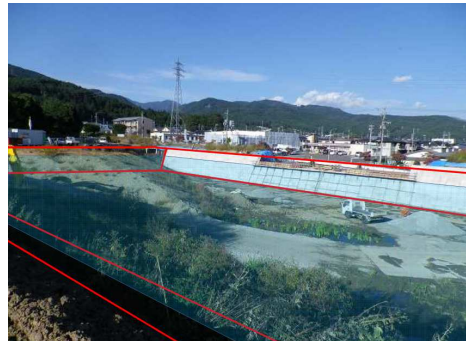
塚間川今井西調節池整備状況
