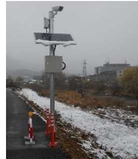
簡易型 河川監視カメラ
