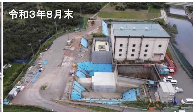
水槽が完成。12月からポンプ据付
