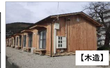
建設型応急仮設住宅
