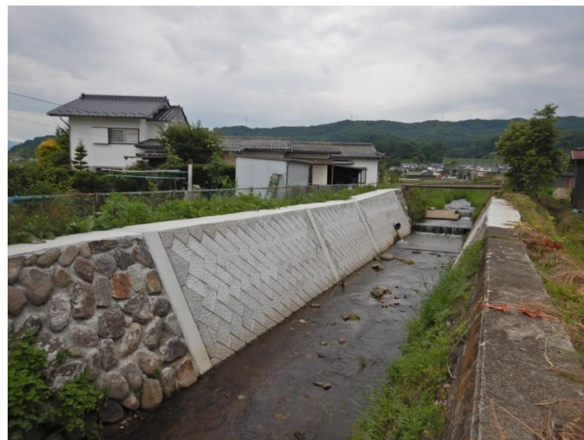
令和3年7月竣工
