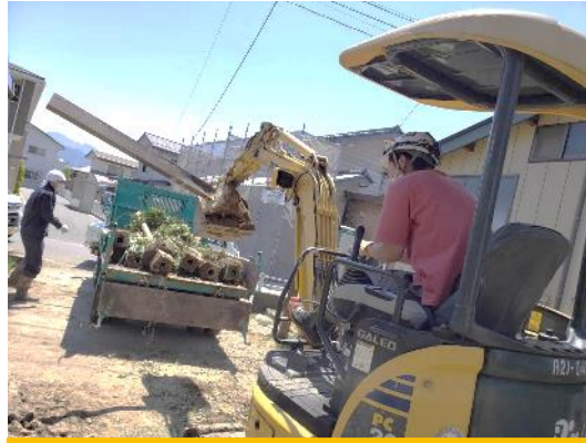
重機を持ち込み災害ごみを撤去
