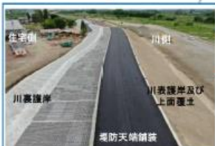
堤防強化(粘り強い河川堤防)
