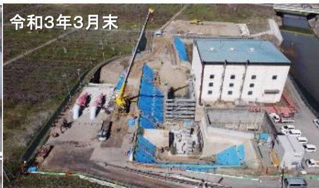
旧機場を解体し、新機場に着手
