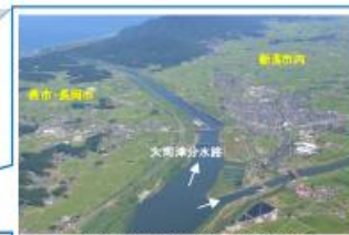
大河津分水路改修事業
