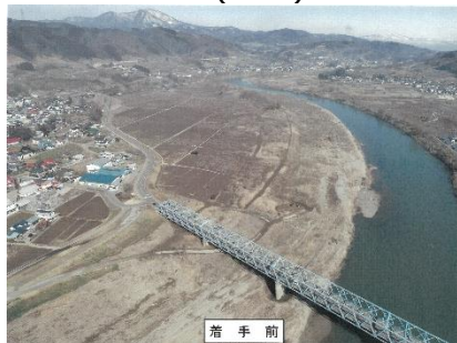
中野市 上今井(長原)地区 農地への土砂堆積の復旧状況
