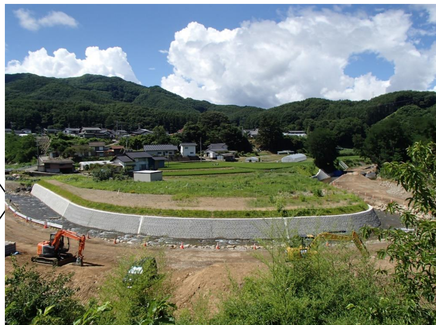
工事中(令和3年8月)
