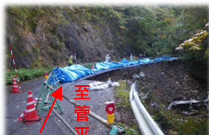
< 着工前 > (令和2年4月)
