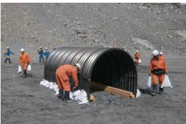
接地部を土嚢で補強(木消)
