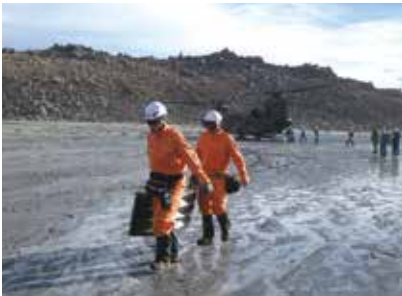
資材をヘリから降ろして設置場所に運ぶ(木消)
